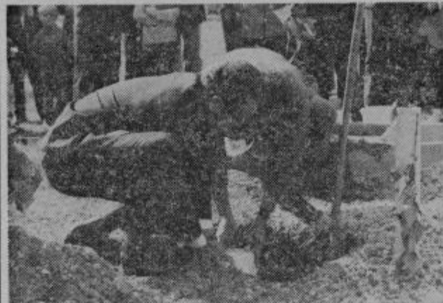
Vgrajen je temelj za telovadnico v Zrečah.
