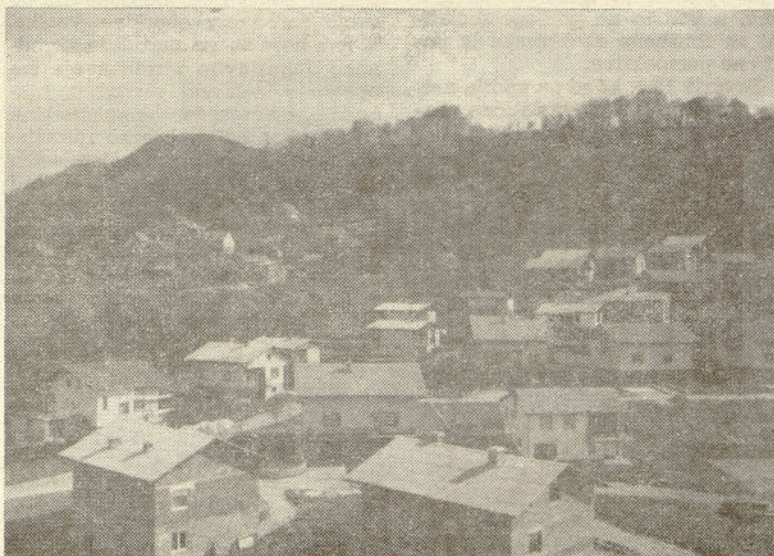
Pogled na del soseske individualnih graditeljev železarne Štore
