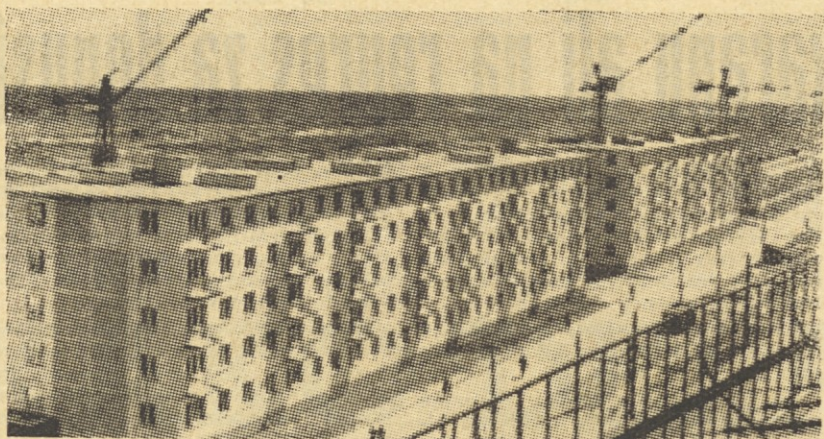
Pogled na stanovanjske bloke
