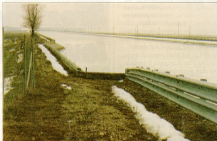
Nerazumno je, da je ob mostu sicer zgrajen spust, a je na koncu zabetoniran z več kot pol metra visoko ograjo. Foto: M. Ozmeč
