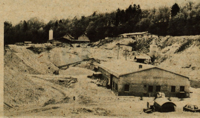
Proizvodna hala za kamnoseštvo in cementne izdelke (opeka) Kranj — Struževo
