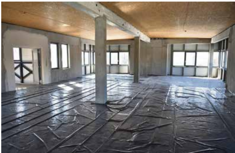
Občina Ivančna Gorica je že izbrala izvajalca za ureditev prostorov v nadstropju nad novo lekarno
