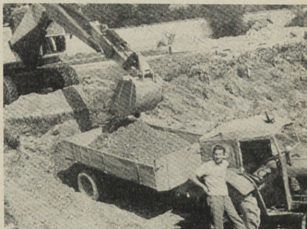
Dela na nivelaciji terena so v polnem teku
