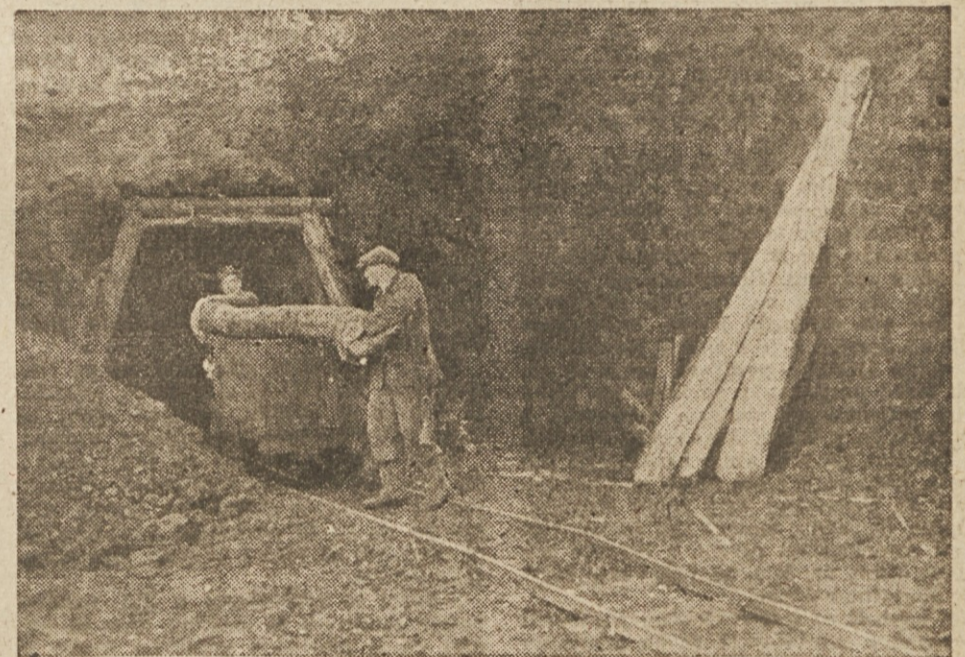
V jamo peljejo na vozličku les za podporneke in stolke, ki se rabijo pri odkopu premoga (rudnik Šemnik)
