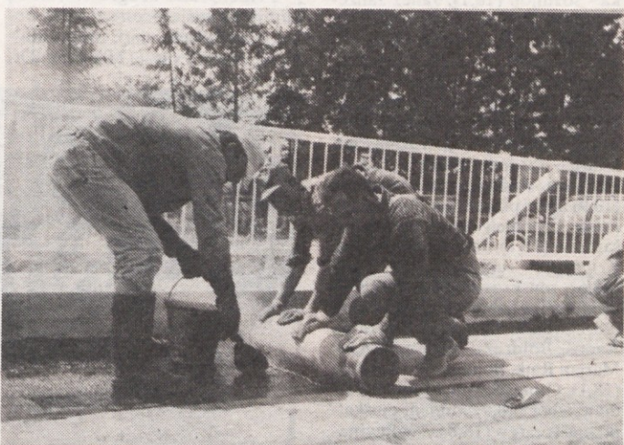
NOVI MOST V DOLENJI STARI VASI - Gradnja novega mostu, regulacija okrog 800 m struge Lačnega potoka, širitev ceste iz vasi proti mostu, ureditev okolice in postavitve javne razsvetljave v Dolenji Stari vasi bo stala okrog 40 milijonov tolarjev. Dela na mostu gredo počasi h kraju, na šli pa so delavci novomeške VGP-ja, ki so konec prejšnjega tedna na mostu polagali izolacijo. (Foto: J. Dornič)
