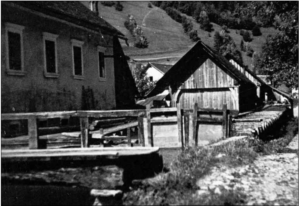
Zapornice v Plnadi, narejene na zelo enostaven način. Levo mlin Plnada, desno žaga Plnada, za njo desno Egrova žaga (vidi se samo streha) in bajer po desni strani, ki oskrbuje Egrovo žago. Fotografijo hranita Bojan in Aljoša Fajfar, Plnada.
