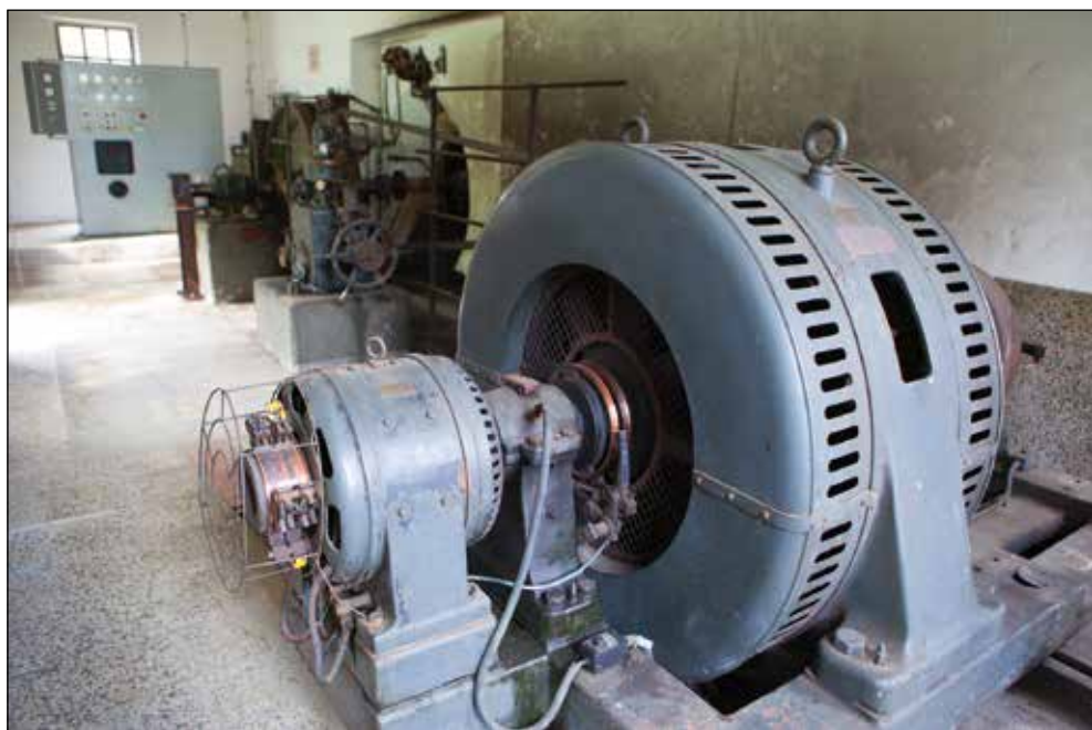
Vzbujevalnik in agregat, zadaj komandni pult, regulator in vztrajnik. Foto: Andrej Bogataj
