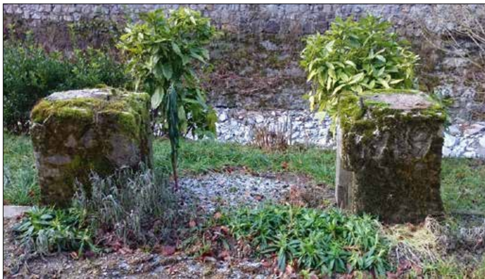
Dva betonska stebra z letnico 1949 na Škarjencu. Naredili so jih ob polaganju cevovoda leta 1949 in sta z zapornico služila za izpust vode iz dela bajerja od Plnade do začetka cevovoda na Škarjencu. Kasneje so tudi v tem delu položili cevi in sta postala samo še spomin na tiste čase. Foto: Andrej Bogataj
