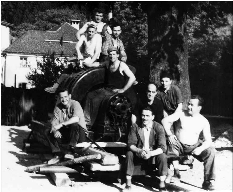
Transport novega generatorja v elektrarno. Od leve spredaj: Stane Potočnik – dolgoletni strojnik v elektrarni, Jože Bogataj in Janez Markelj. Za Jožetom Bogatajem sedi Janez Demšar, za njim Janez Košir. Na vzbujevalniku sedi Metod Šturm. Na agregatu sedijo z leve: Franc Šubic, Franc Čufer in Franc Franko. Fotografijo hrani Peter Poljnar.
