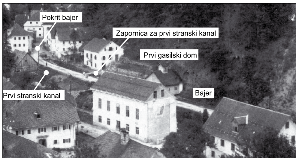
Fotografija Racovnika, na kateri se vidi potek bajerja Na klovžah. Poteka pod prvim gasilskim domom, mimo danes Benedičičeve hiše. Od Štolmarja naprej mimo Antona Globočnika je bil pokrit. Vidijo se leseni mostički k posameznim hišam in ograja. Fotografijo hrani Muzej Železniki.
