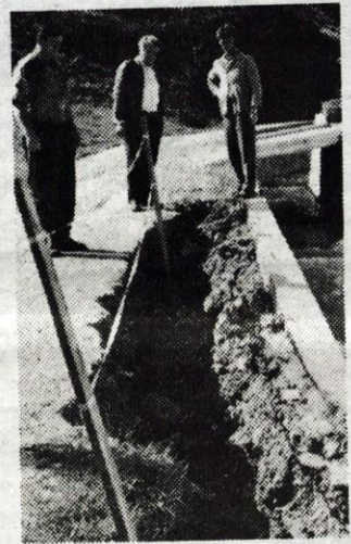
Potok Podosojniščica nad Sovodnjem je narasel, da tudi starejši ljudje ne pomnijo tolikšne vode.
