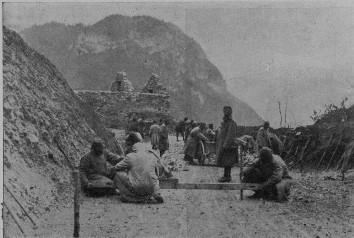
S tirolske fronte: Naše vojaštvo gradi novo cesto čez hribovje.
