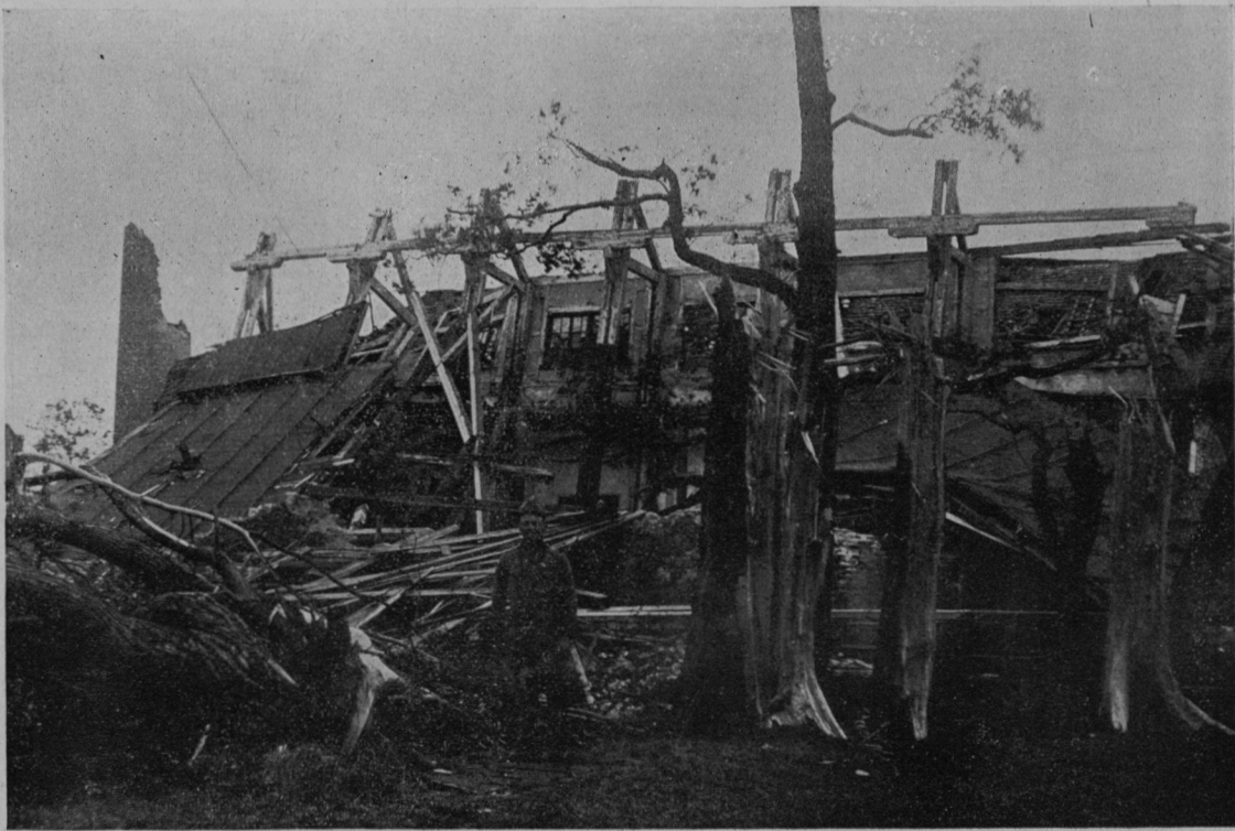
Ruševina hiše in polomljena drevesa v Dunaj. Novem mestu.
