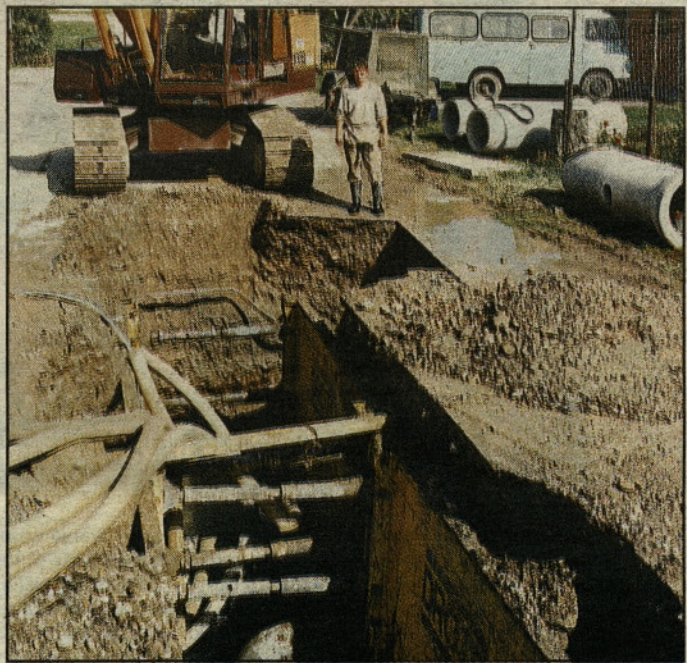
Pri gradnji III. faze primarnega voda kanalizacije v središču Vrbja.
