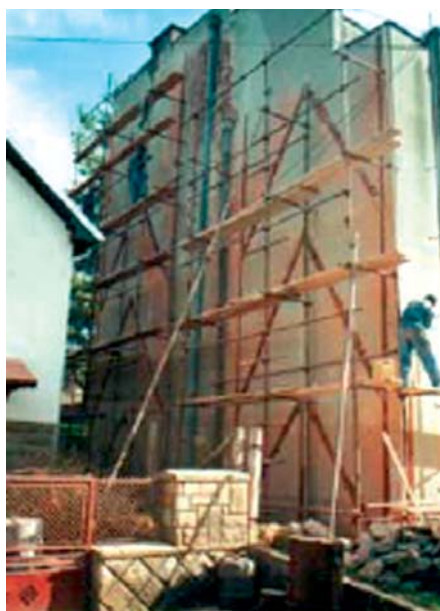
Slika 2 • Dva primera vgradnje jeklenih povezij z dušilci v steno zidanega objekta
