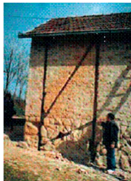
Slika 2 • Dva primera vgradnje jeklenih povezij z dušilci v steno zidanega objekta
