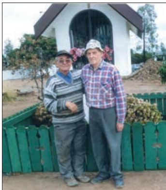
Štefan Šernek in Ivan Truden, naša pridna delavca, ki sta gradila ograjo okrog kapelice.
