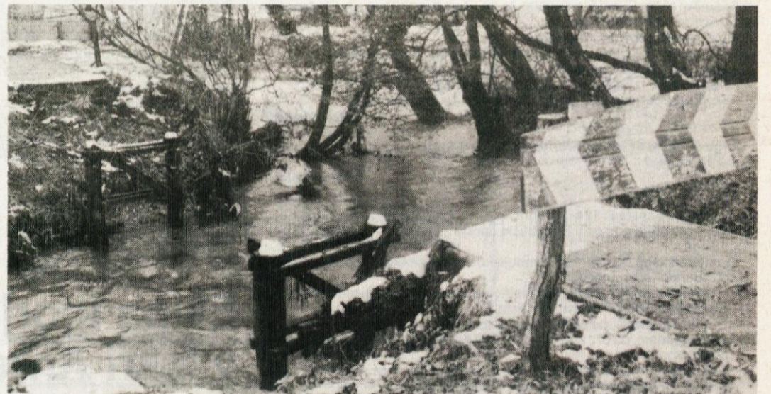
Veliko deževje in narasli potoki so naredili tudi nekaj škode. Slika prikazuje, da je narasli potok Bela že v oktobru odplaval leseni mostiček v Gradišču, takoj za podjetjem Drogo. Ker ni dočakal pravočasnega popravila, je voda naredila svoje in sedaj ga ni več. Najbrž pa bo še precej vode »Bele« preteklo, da bo postavljen nov most. N. Č.
