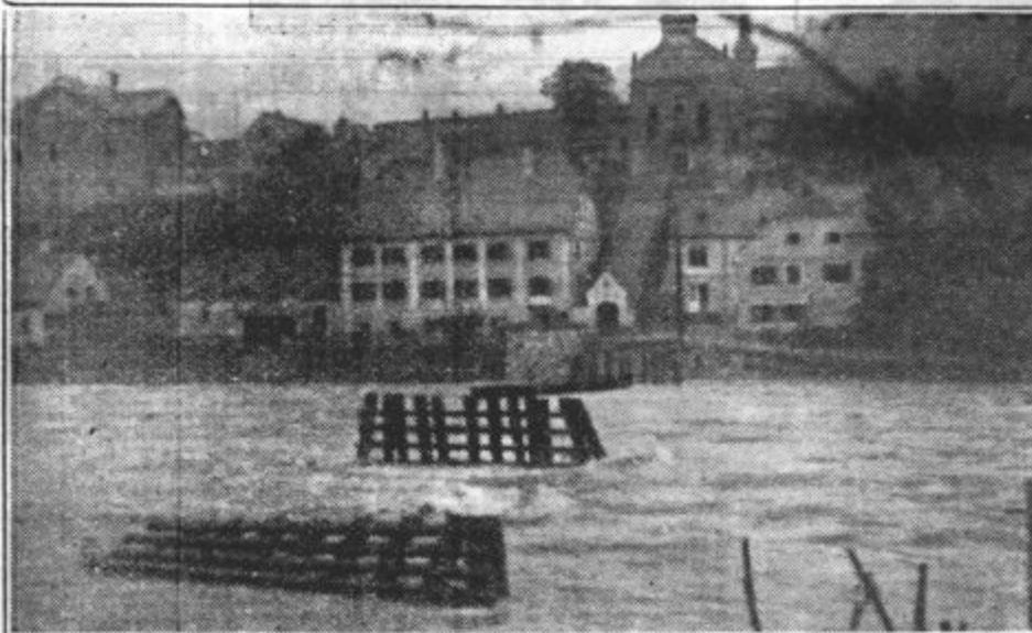
Ostanki porušenega kapucinskega mostu v Celju
