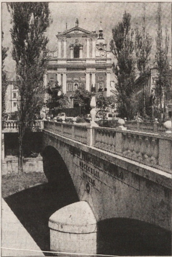
Plečnikova prenova starega središčnega kamnitega mostu, ki ga je nadvojvodi Francu Karlu v čast postavilo mesto Ljubljana leta 1842
