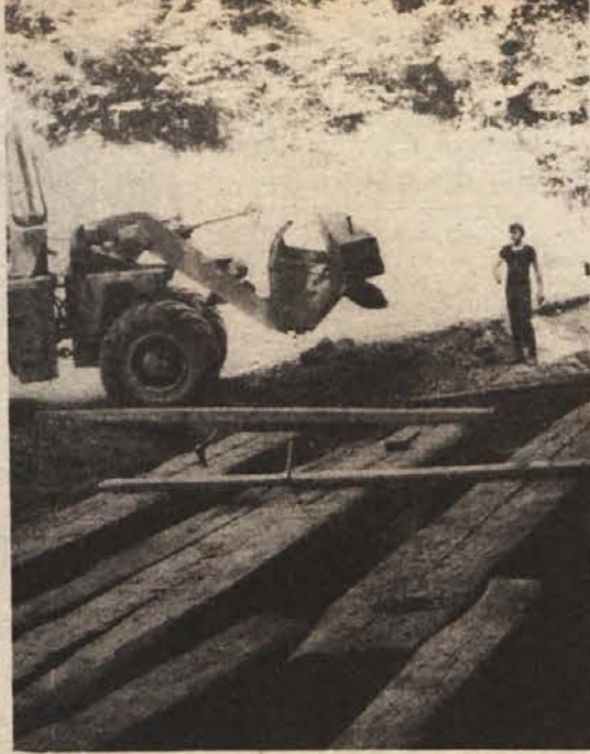
NOV MOST NA DELAVSKI PROGI – Delavci cestne službe pri sevniški krajevni skupnosti so konec prejšnjega tedna postavili trden zasilni most na Vranjskem potoku v Vranju. Čezenj bodo preusmerili promet, ker bodo pričeli graditi nov betonski most na delavski avtobusni progi Sevnica – Podvrh. (Foto: P. Perc)
