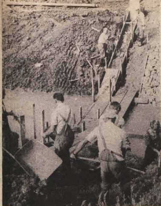
DRAGA DELA GREDO H KONCU – Za melioracijo stotih hektarjev zemljišč, ki narekujejo izvedbo komasacij na 120 ha, so najprej nujne regulacije. Delavci novomeškega vodnogospodarskega podjetja opravljajo zaključna dela na potoku Lokavcu s pritokom Orehovcem. (Foto: P. Perc)
