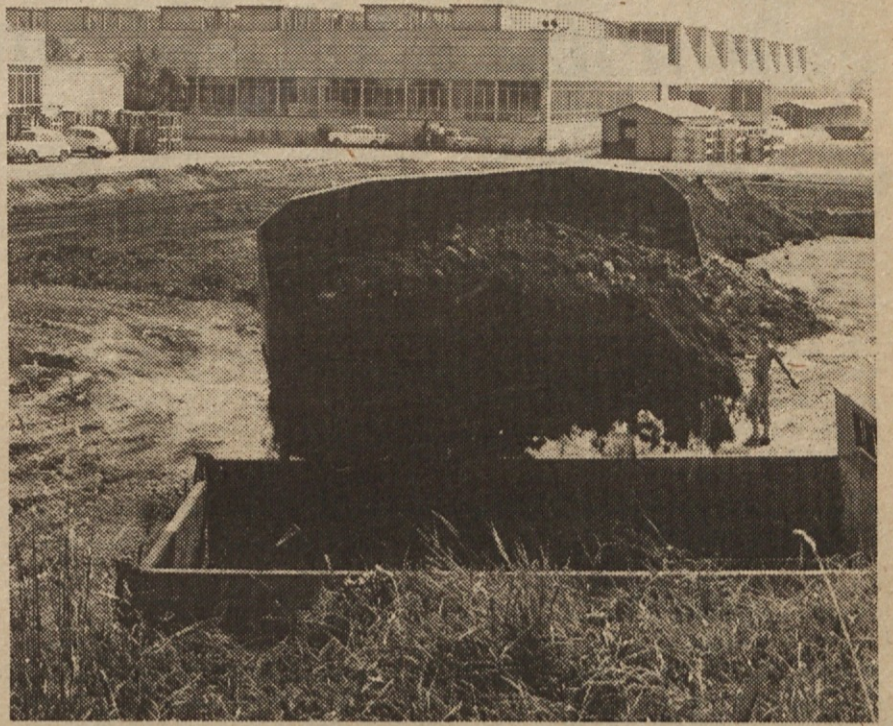
Na Stegnah v Ljubljani se je v zadnjih letih Iskra že močno razmahnila. Dosedanjim tovarnam se bo pridružil nov obrat tovarne Aparati, oz. bolje pred dnevi se je začela gradnja novega obrata signalnih naprav, poleg že obstoječega objekta, ki ga ta obrat deli s tovarno orodij. Gradnjo novega obrata bomo v „Iskri“ sproti spremljali v sliki in besedi.
