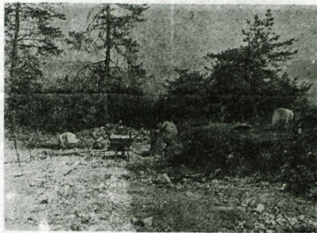
Izkop temeljev za TV stolp. Foto: Zofka
