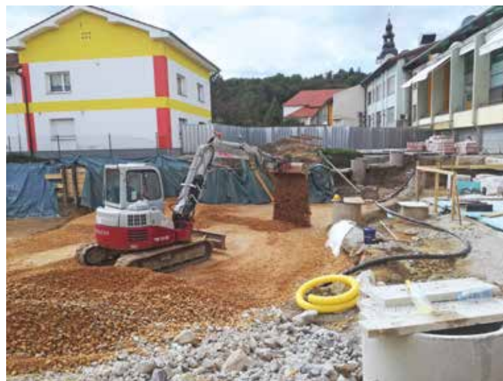
Gradbena dela ob Govekarjevi cesti – 2. faza
