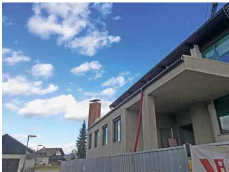
Gradnja prizidka ob Troštovi ulici – 1. faza
