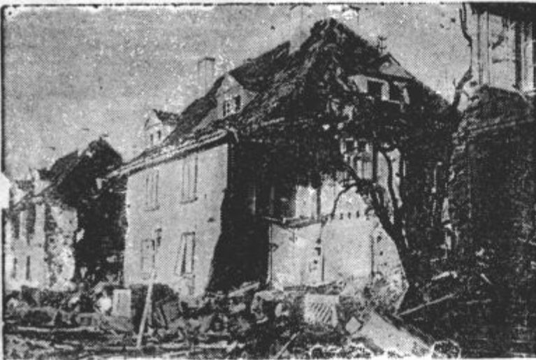
SLEDVI VOJNE MED MAGINOTOVO IN SIEGFRIEDOVO LINIJO bi bili prilléno pičli, če bi kakšna granata tu in tam ne podrla kakšne brezpomembne stavbe. Slika nam kaže porušene zgradbe neke nemške carinarnice
