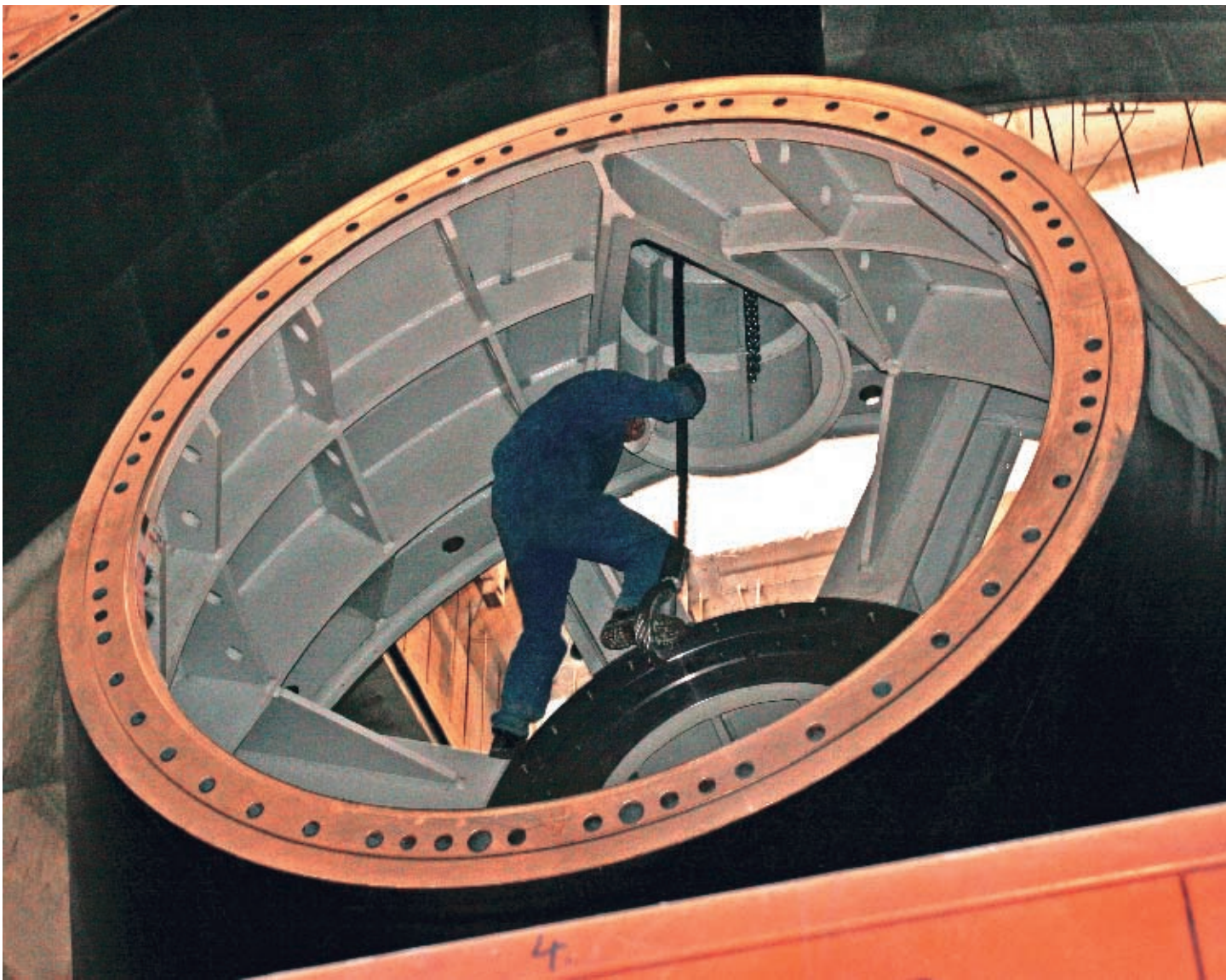
V HE Boštanj pospešeno delajo na montaži opreme.
