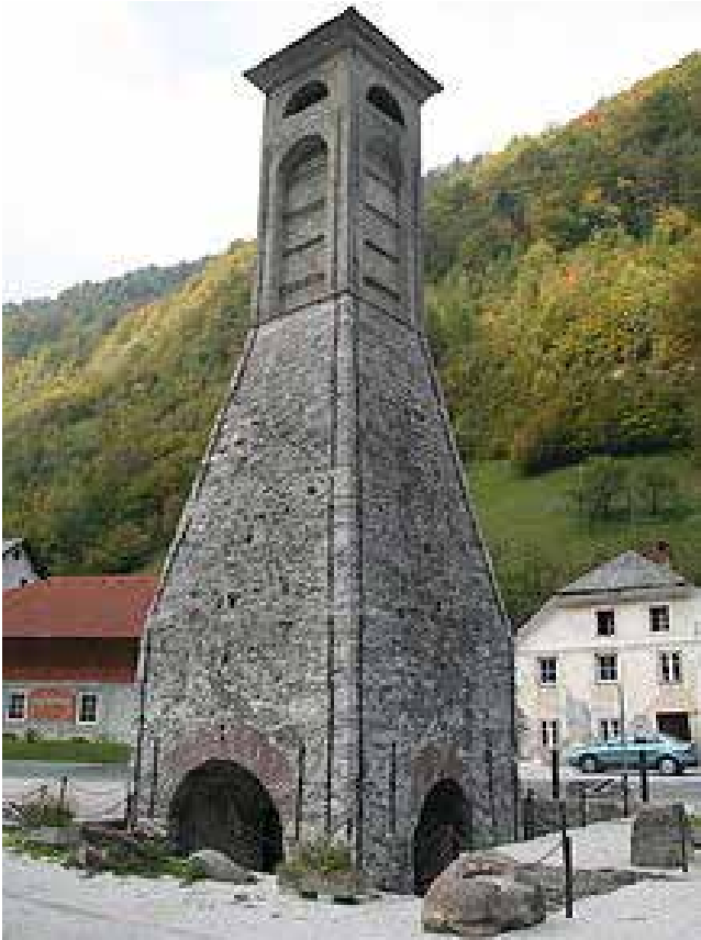
Slika 4 : Plavž v Železnikih, v katerem so do leta 1902 talili železovo rudo. To je edini ohranjen plavž v Evropi. [4]
