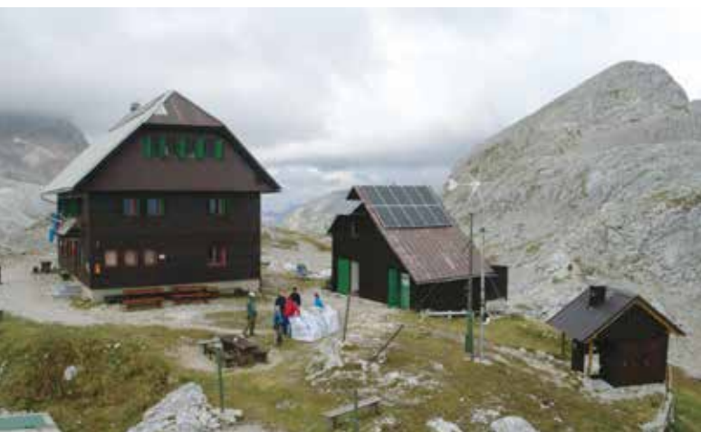
V planinski koči Dom Valentina Staniča pod Triglavom (2332 m) električni generator na fosilna goriva ni več potreben
