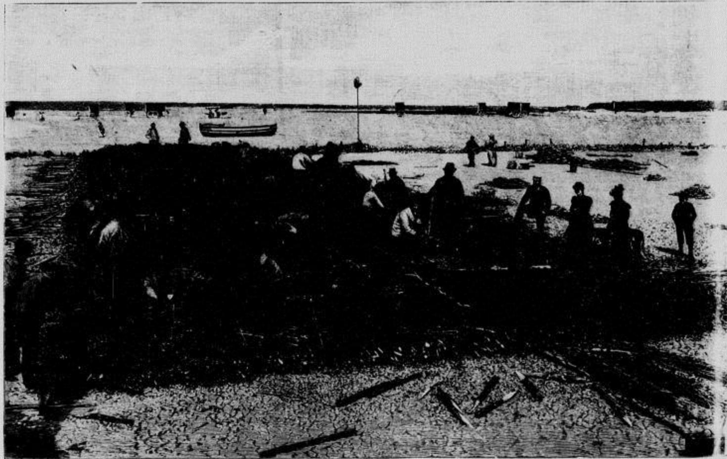
Arbeiten zur Erhaltung der Helgoländer Düne: Herstellung eines Sackfüßs. (Mit Text.)
