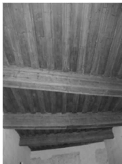
Profilirani leseni stropi v prvem nadstropju vzhodnega trakta (foto: Igor Sapač, 2012).
