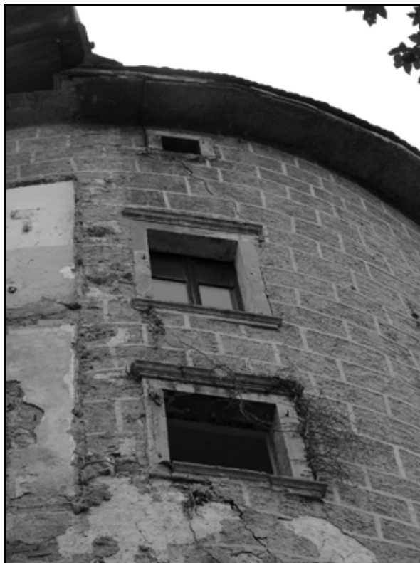
Leta 2011 na zunanjsčini valjastega stolpa v vrhnjem delu odkrita rustikalna arhitekturna poslikava iz zgodnjega 17. stoletja (levo) in kamniti renesančni okenski okviri iz zgodnjega 17. stoletja v prvem in drugem nadstropju valjastega stolpa (foto: Igor Sapač, 2011).
