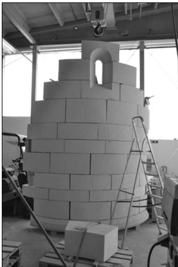
Izklesani manjkajoči elementi apside romanske grajske kapele pred vgradnjo (fototeka ZVKDS OE Ljubljana).
