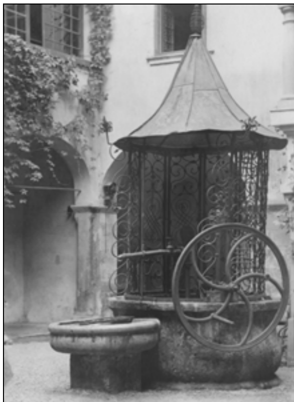
Kamnita krona in kovani nastavek iz okoli leta 1600 nad cisterno za vodo na dvorišču gradu Sevnica pred drugo svetovno vojno (zasebna zbirka).
