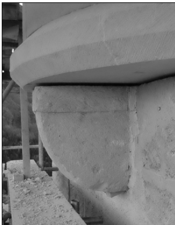
Konzola apside na vzhodni fasadi romanske kapele in sled porušenega originalnega oboka v notranjščini kapele ob jugovzhodnem vogalu (foto: Igor Sapač, 2012).
