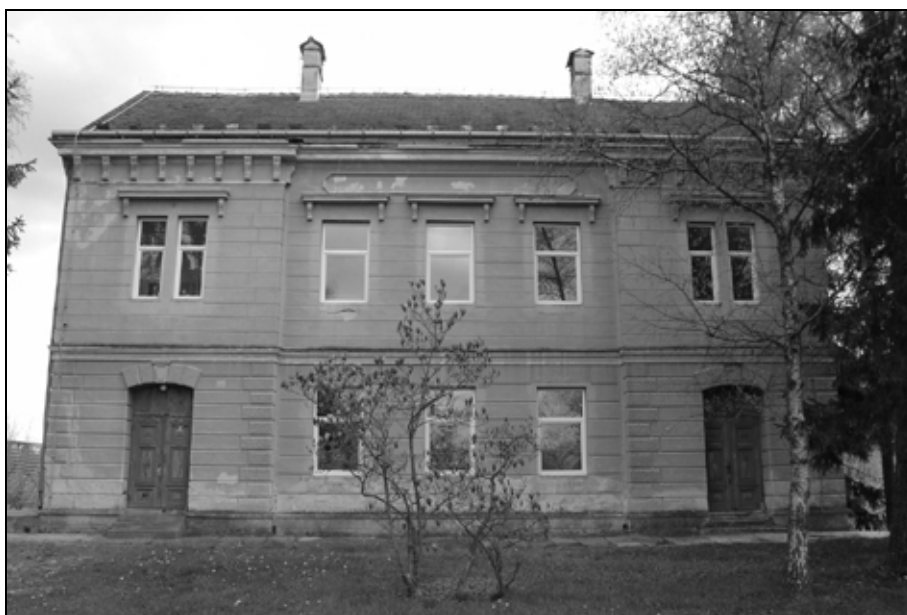
Historistična glavna fasada stavbe za proizvodnjo čokolade in likerjev (foto: Igor Sapač, 2012).
