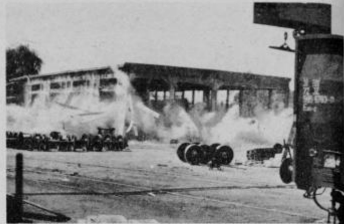
Trenutek eksplozije — uspešno delo Geološkega inštituta iz Ljubljane
