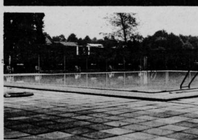
Kopalšiški objekt v Slovenski Bistrici se uvršča med najlepše tovrstne objekte v severovzhodni Sloveniji
