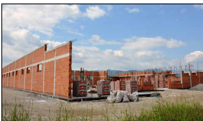
V Latkovi vasi so začeli z gradbenimi deli na območju bodočega trgovskega objekta.
