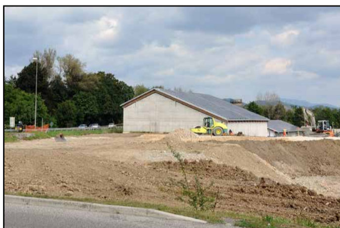
Urejanje terena za gradnjo krožišča
