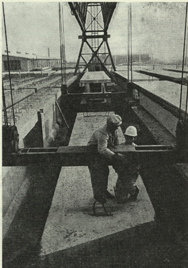
Slika 12 Transport nosilcev v deponiji
