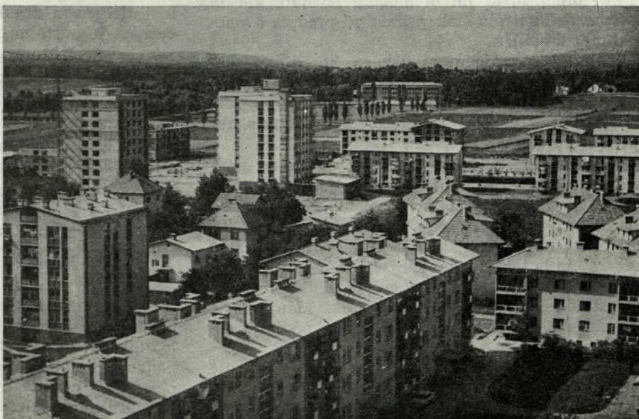
Izgradnja severnega dela v Kranju
