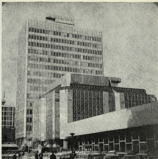
Blagovnica Metalka, Ljubljana — izvajali smo montažo steklenih DELTA prizem, zasteklitvev objekta in dobavo specialnih securativnih vrat 400 × 200 cm.
