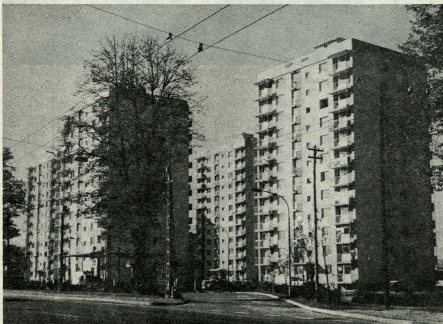
Stanovanjske stolpnice v občini Ljubljana—Bežigrad
