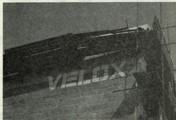
4 Stanovanjski blok iz VELOXA — Vižmarje, »Stavbenik« Koper
