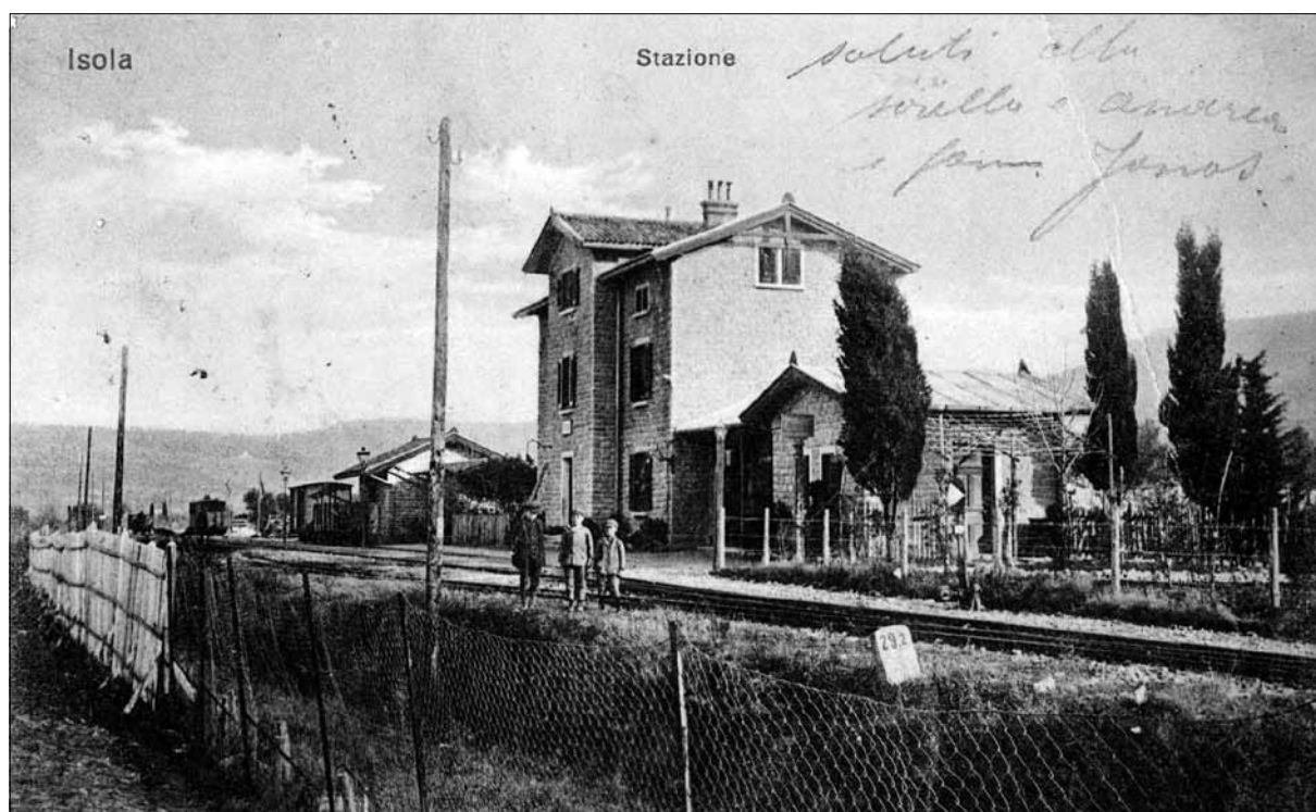
Železniška postaja v Izoli (Zbirka Mestne knjižnice Izola)
