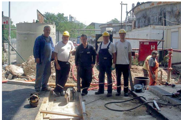
Ekipa za obnovo železniškega tira
