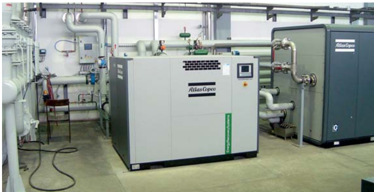
Slika 1: Toplotni izmenjevalnik za odjem odpadne toplote novih kompresorjev
