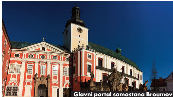
Glavni portal samostana Broumov
