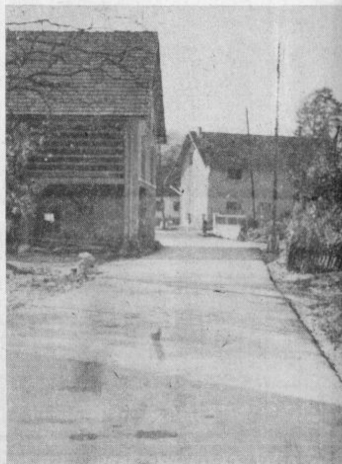
NOVA ASFALTNA PREVLEKA SKOZI PASKO VAS
