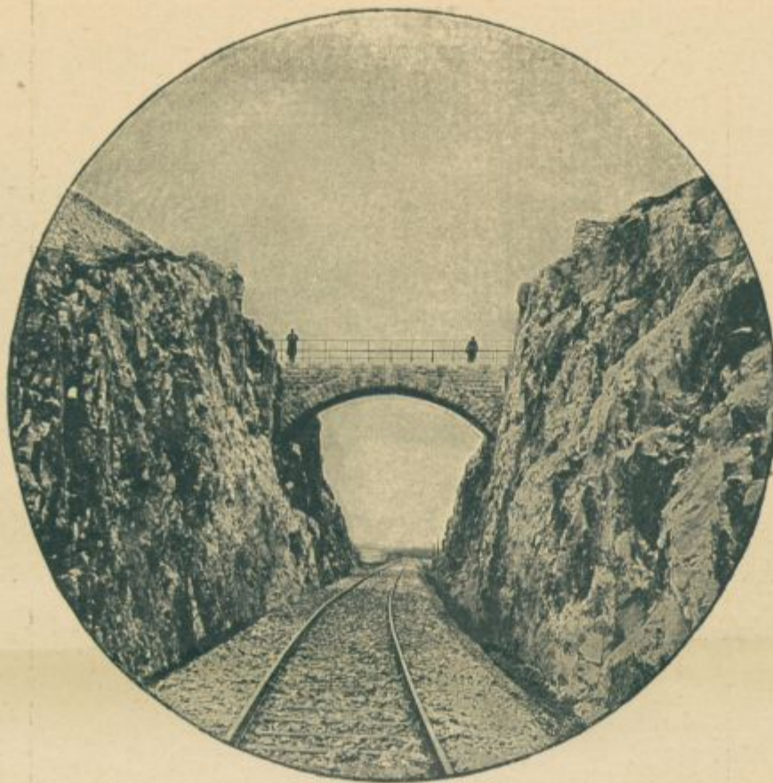
Del železnice proge Jesenice—Gorica—Trst: Mostič pred predorom pri Opčini.
