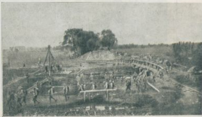
Prehod čez most za silo.
