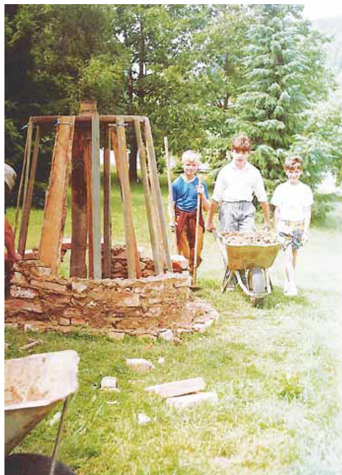
Gradnja lončarske peči, 1991
