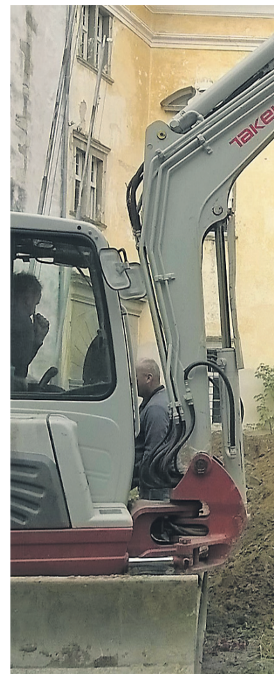
Urejanje odvodnjavanja meteornih voda
