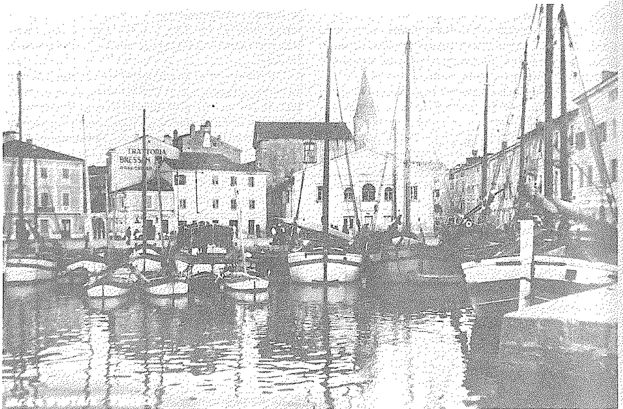
Pristanišče v Izoli. Fototeka PMK, št. 226.
