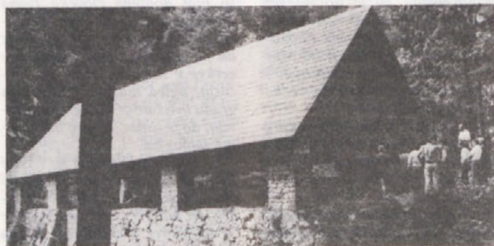
Pogled na klavže, v levem kotu odprtina, skozi katero je voda odnesla les v dolino. (F. J. Blažič)
