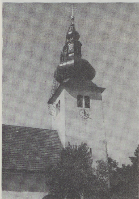
Obnavljanje stolpa župnijske cerkve v Cezanjevcih
