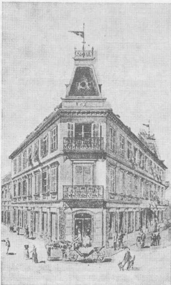
Hotel Nadvojvoda Ivan (Erzherzog Johann) v Mariboru zdaj stanovanjska in poslovna hiša na vogalu Gosposke in Slovenske ulice
