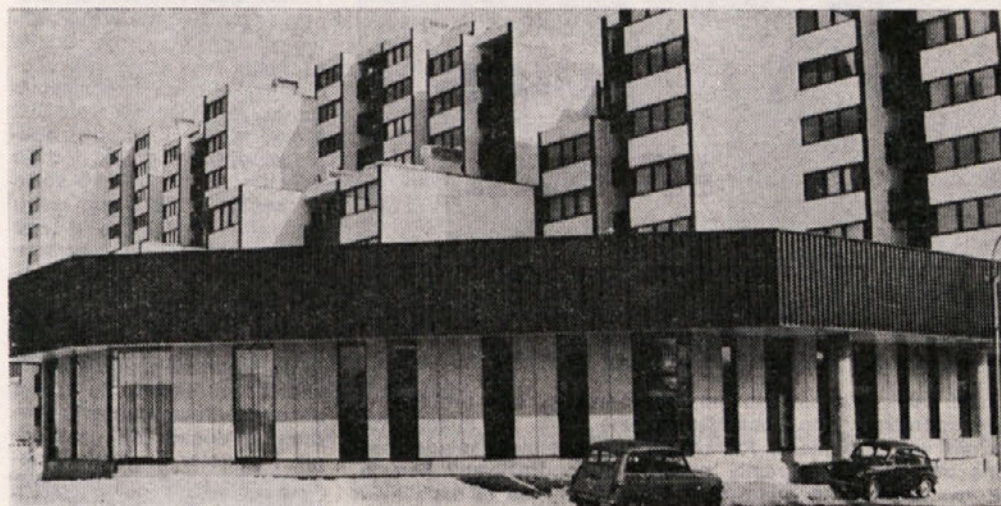
Poslovno stanovanjski blok v Domžalah — skupno delo Beton-Zasavja in Ingrada.
