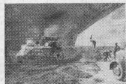
Vgrajevanje zadnje plasti tampona na cesti Rimske Toplice—Zidani most. Na marsikaterem odseku je bila potrebna naj sodobnejša mehanizacija, da so mogli uravnati skalovit teren.
