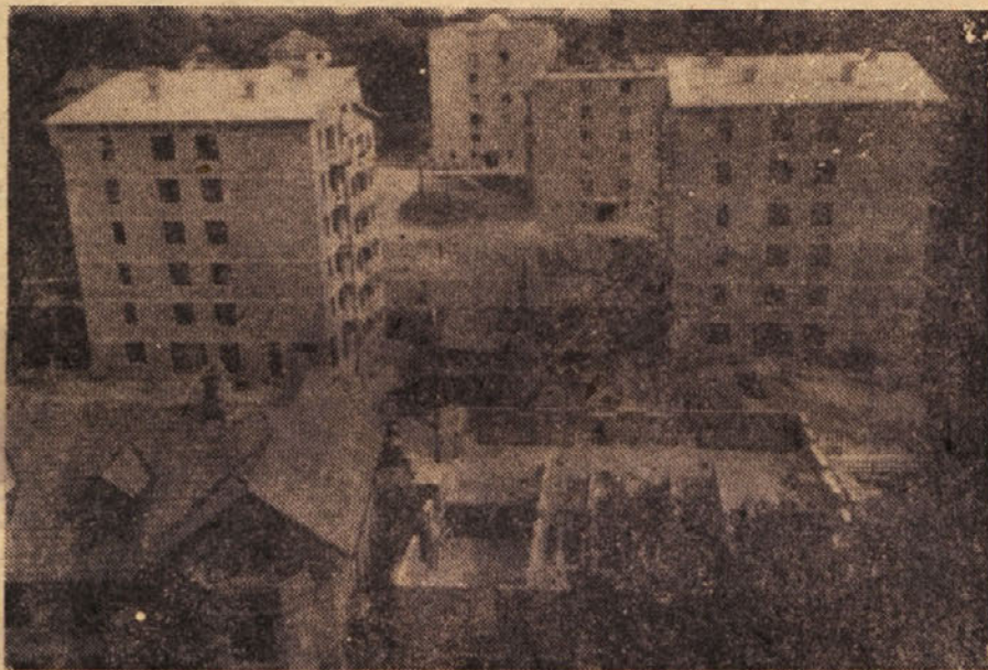
V zadnjem času so v Trbovljah začeli graditi več stanovanjskih blokov z zidaki iz elektrofiltrskega pepela
