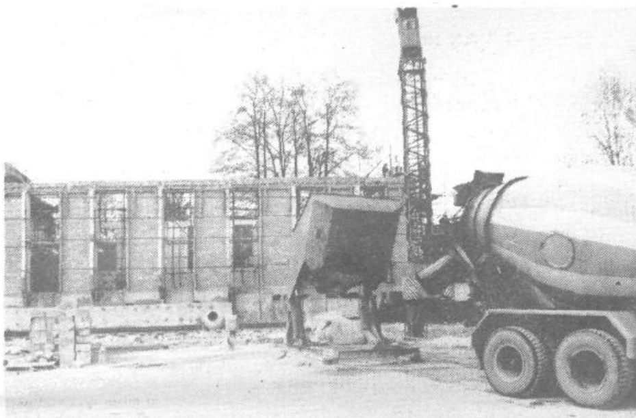
Gradnja telovadnice pri OŠ v Velikih Laščah napreduje
