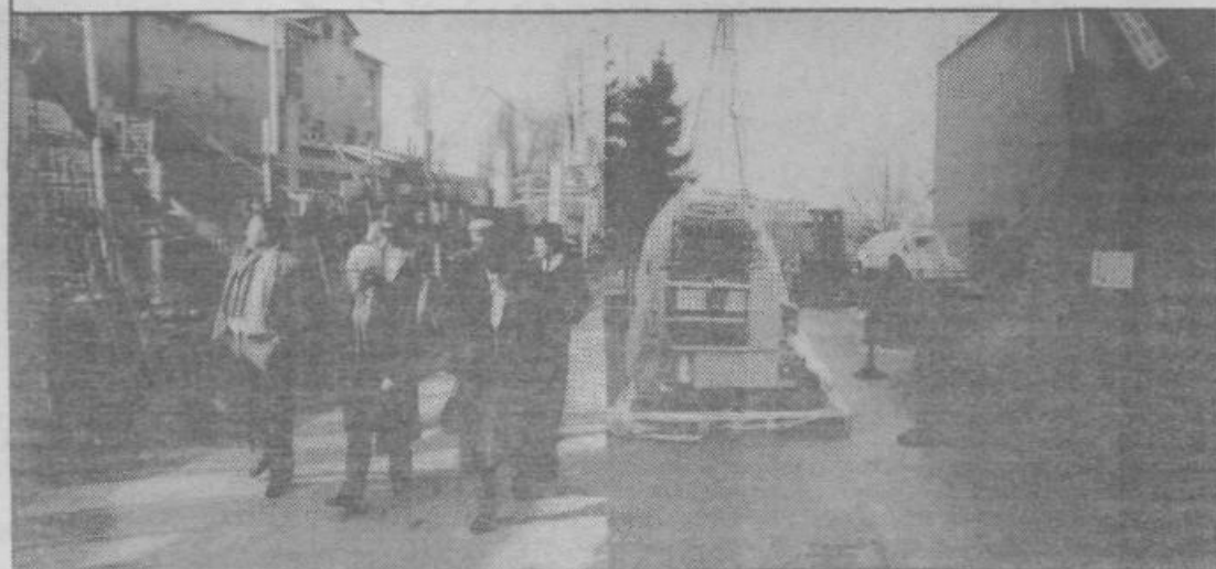
Vinko Hafner si je z zanimanjem ogledal gradbišče nove proizvodne dvorane
