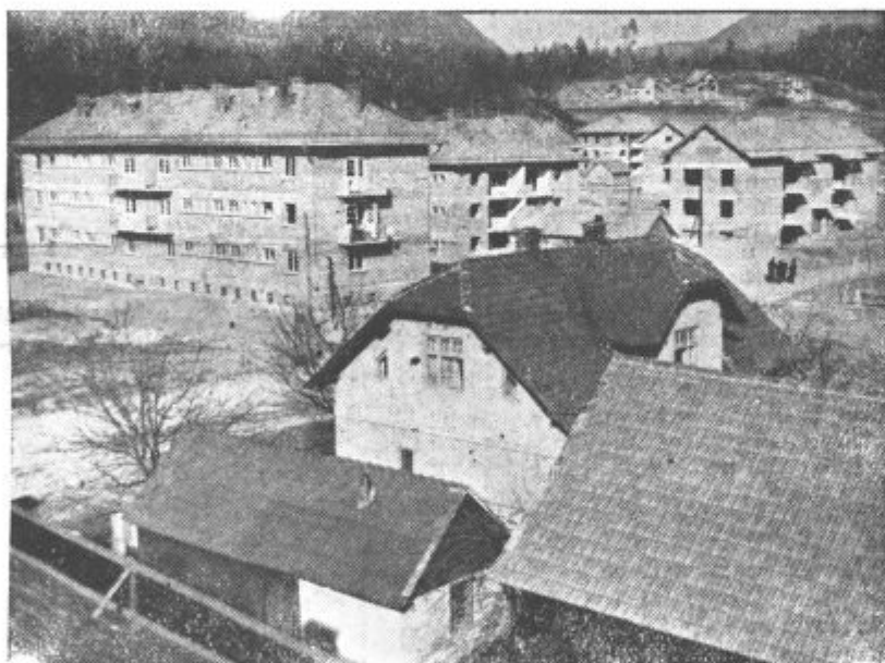
Naglo napreduje dovršitev rudarskih stanovanj Te stavbe so danes že skoraj vse gotove in naseljene
