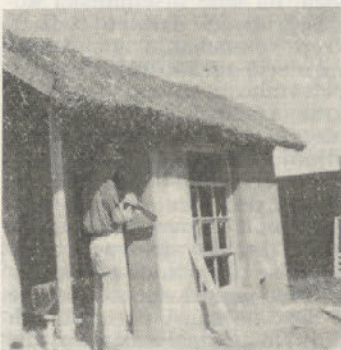
Gradnja kurnice za razstavo v Ptuj 1956 (Foto: S. B.)
